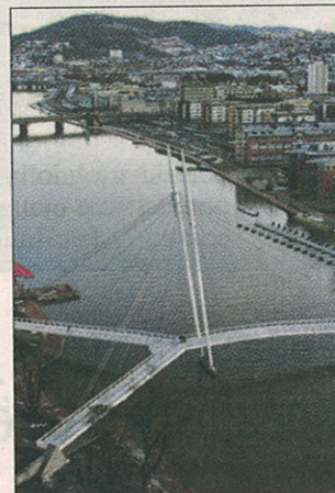
Tämä silta on Norjan parasta teräsrakentamista.
